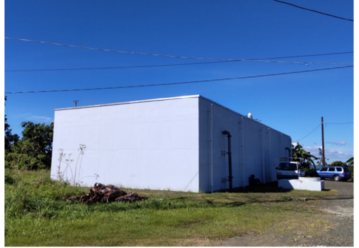
本事業で新設したマラカル配水池 (出典：評価者撮影)
