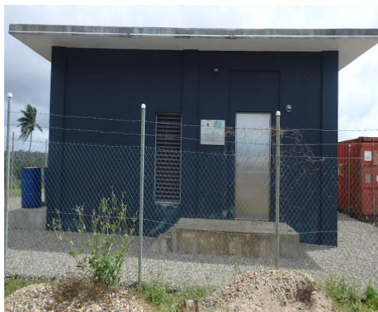
本事業で整備した送信機建屋の外観
