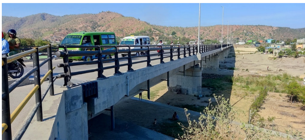
写真 4：整備された日の出橋（1）
