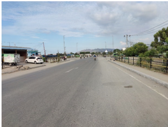
写真 6：整備されたアクセス道路
