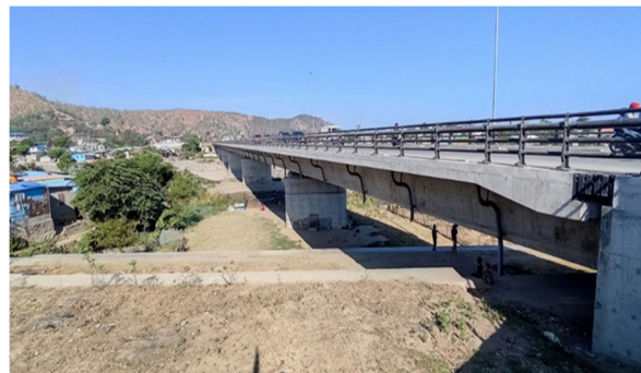
整備された日の出橋
