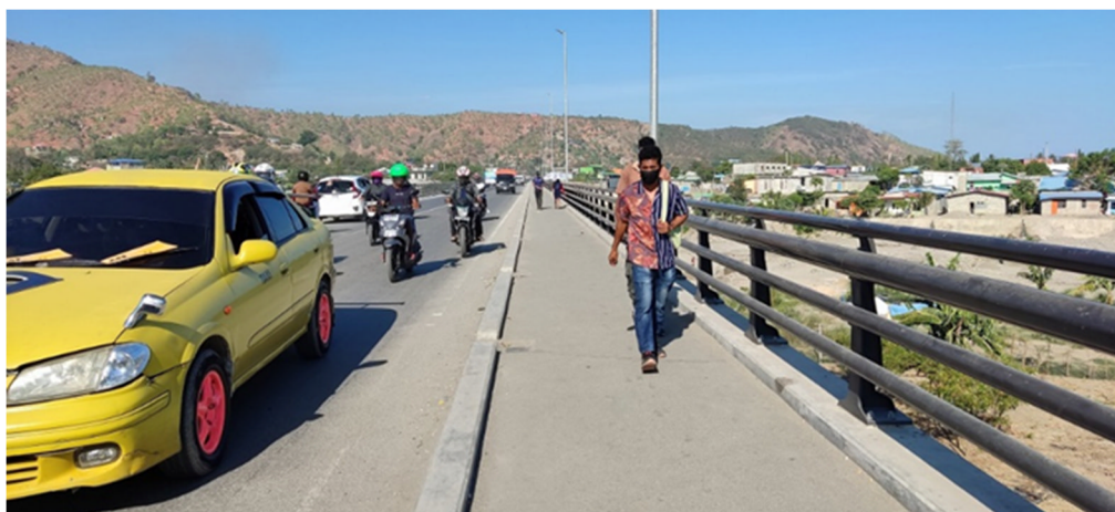
写真 5：整備された日の出橋（2）
