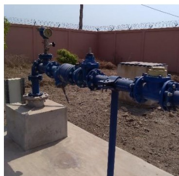
ダッサズメ市水源施設 (3-SE8) (評価者撮影)
