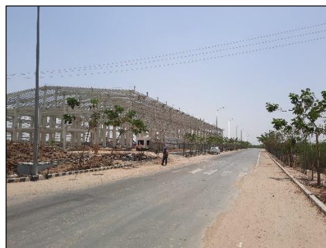
本事業で実施された小規模インフラ事業 (バガプール工業団地内の道路整備) (出典：評価者)
