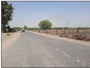
第2 サナンド工業団地への接続道路
