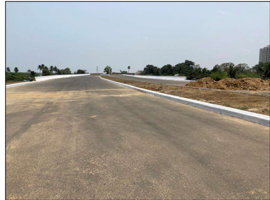
本事業で実施された小規模インフラ事業 (バイパス道路建設)（出典：評価者）
