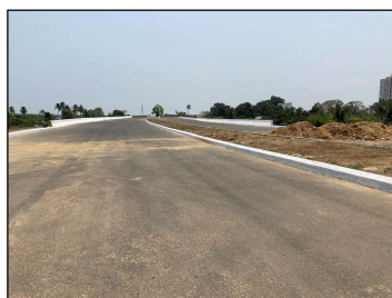
バイパス道路建設
