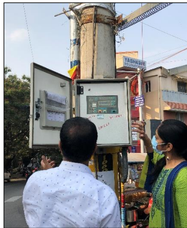
配電自動化対応区分開閉装置
