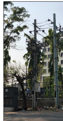
配電自動化対応区分開閉装置
