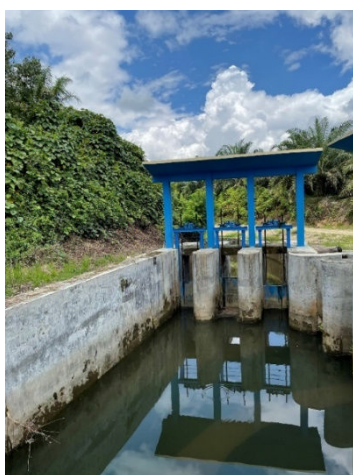
写真3: 排水路施設 (トンモ灌漑地区)
