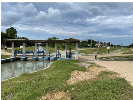
写真1：一次・二次用水路の分岐箇所 (ムベイ・キリ灌漑地区)
