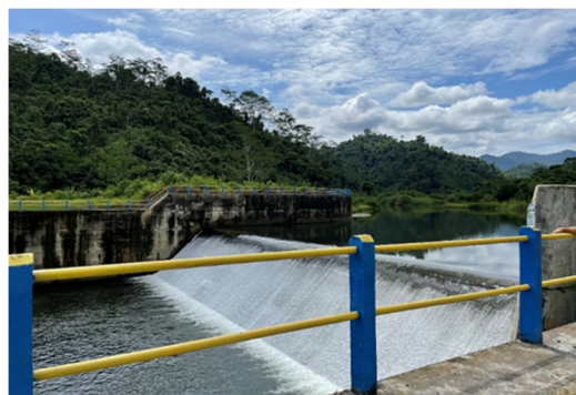
整備された堰堤（トンモ灌漑地区）
