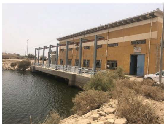
東ガラーフ排水ポンプ場 （出典：事後評価チーム 1 ）
