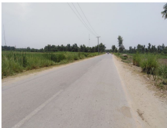
修復後の地方道路（マルダーン地区）
