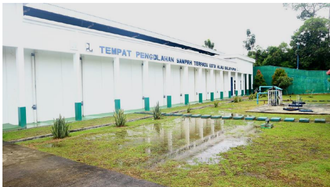
バリクパパン市内の中間処理施設
