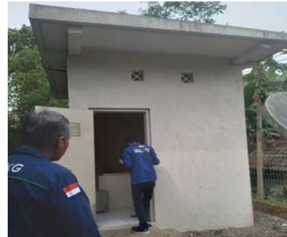
地震観測機材設置のため建設された 観測所
