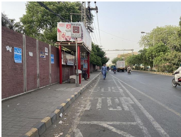
TMP のアクション 1 に基づいて TEPA が移設した バス停看板及び設置した「BUS STOP」の路面標示
