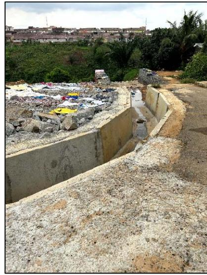
写真6 フェーズ2で補強された流末
