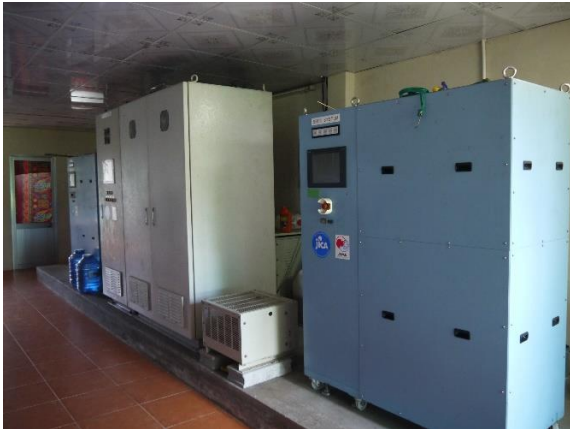
ベンチェ省の実証サイトに設置された SOFC システム 及び配電制御盤
