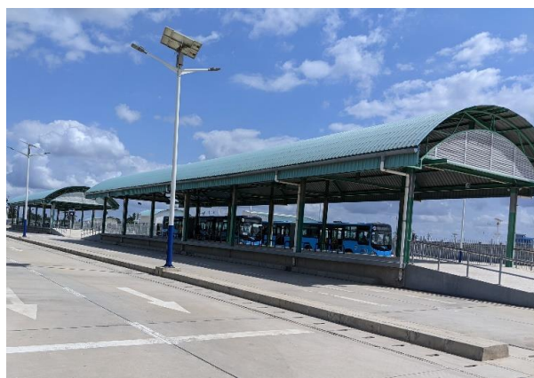
ダルエスサラーム市で建設中のBRTフェーズ2プロジェクト
