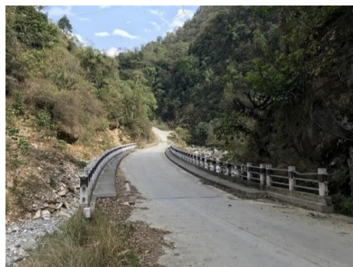
バラキローバルパック道路橋梁事業対象の ラングルン河橋 (出典：外部評価者)
