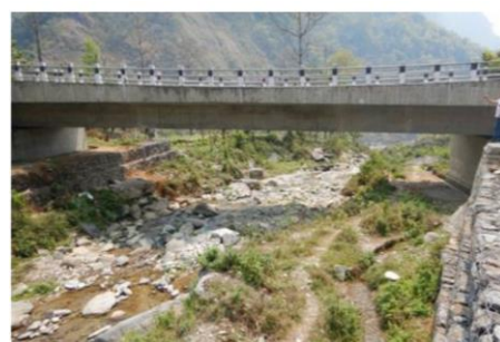
写真6 ガッテ河橋 (事後評価時点、出典：外部評価者)
