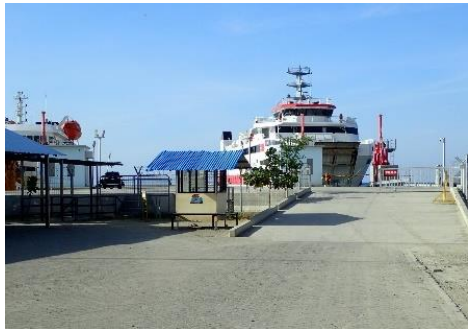
新フェリーターミナル(フェリーへの通路) (出典: 評価者)
