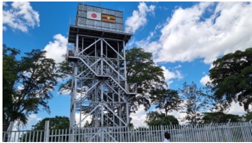
高架水槽（カパラ）
