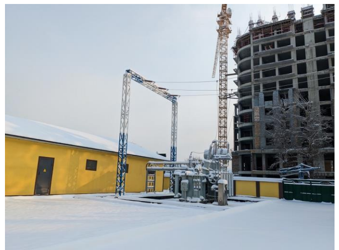
実施機関が本事業後に独自に整備した小規模変電所 (出典：外部評価者撮影)
