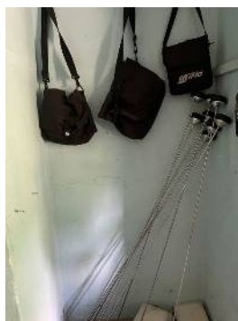
PWD Curtorim の漏水探知機器。機能している。
