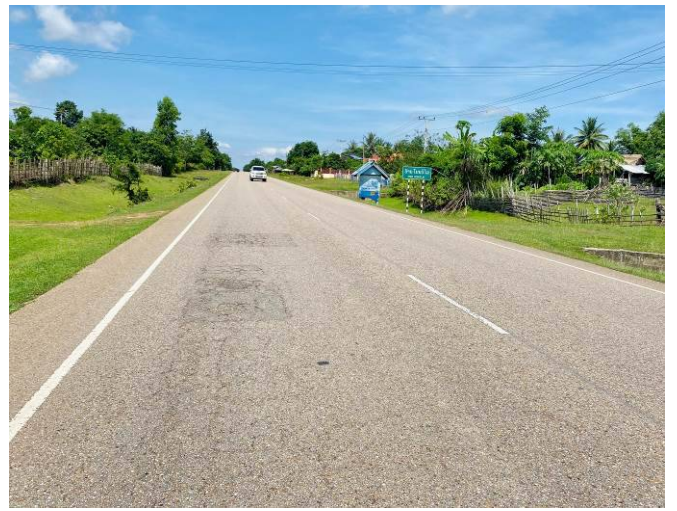
本事業実施後、毎年整備されている国道9号線の一部区間
