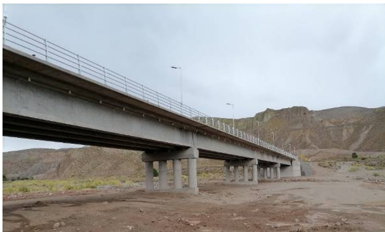
建設された橋梁（サンアントニオ・デ・エスモルコ、2021年）
