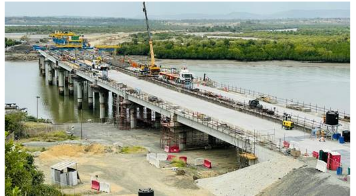
モンバサ南バイパス道路工事 (実施中)
