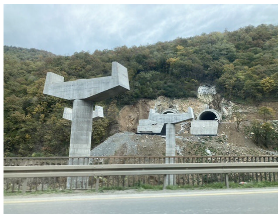
写真4：ゼスタフォニより東側のショラパニ～アグヴェダ間の道路工事の様子
