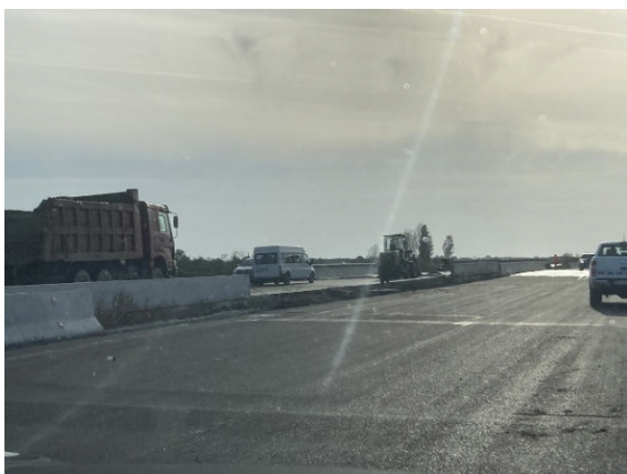
写真3：サムトレディアより西側の道路工事の様子
