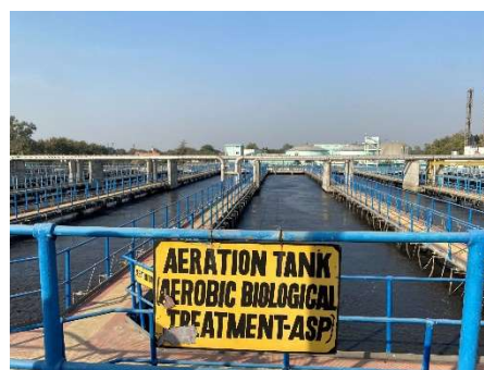
エアレーションタンク (反応槽) (評価者が撮影)
