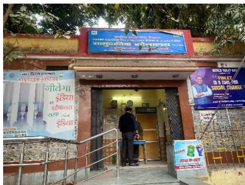
本事業で建設された公衆トイレ
