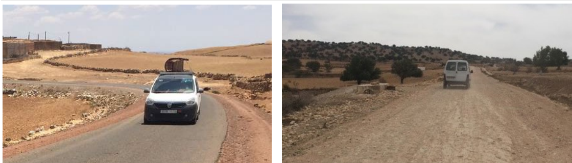
整備された地方道路（左：サフィ県）（右：エッサウイラ県）
