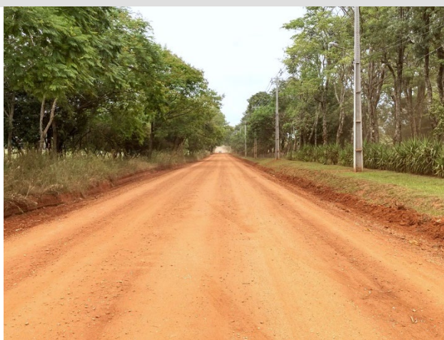
砂利舗装された地方道路 1
