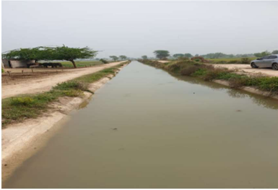
整備された第三次水路
