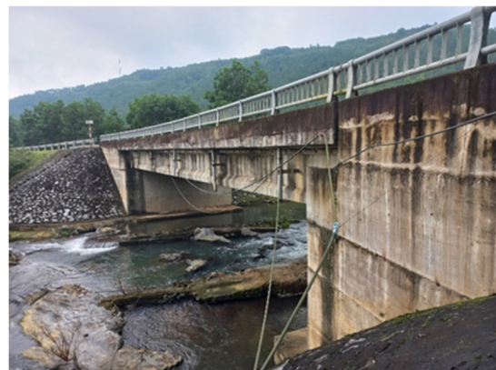
写真2：Soong 橋（クアンビン省） （出典：評価者撮影）
