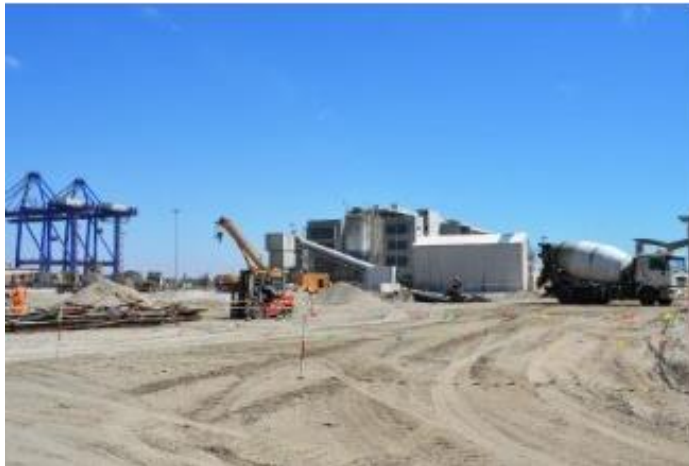
ウォルビス・ベイ港新コンテナ・ターミナル工事現場
