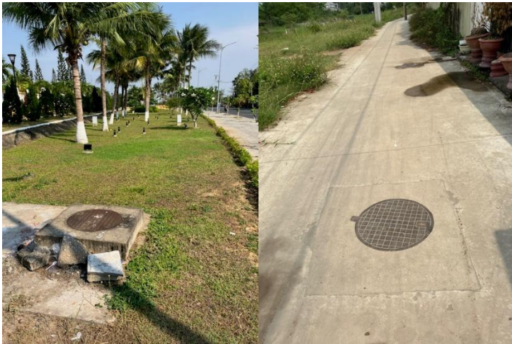
改修された水路 (出典：評価者撮影)
