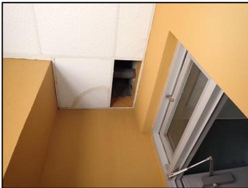
写真5 第一回現地調査で確認した雨漏り箇所（第二回現地調査時には修繕済み）（出典：評価者撮影）
