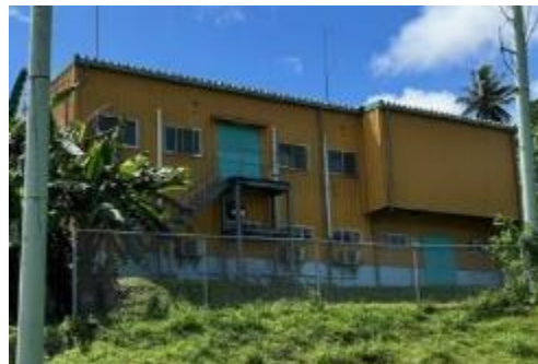
新設発電所（出典：外部評価者）
