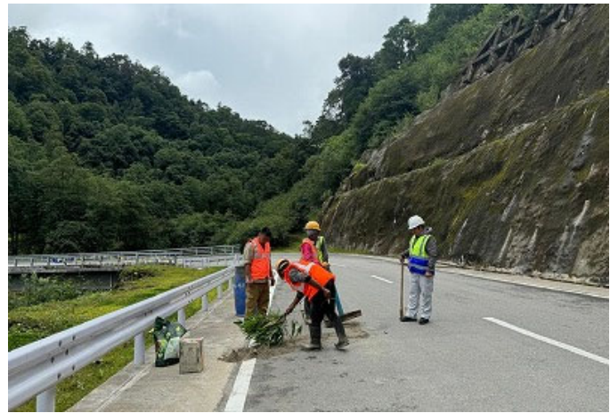
テレガンチュ橋の取付道路のポットホール補修作業 （出典：DoR）
