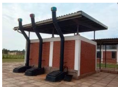
写真2 本事業で整備された便所棟（裏側）
