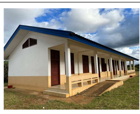
写真 1 本事業で整備された校舎 （出典：評価者撮影）
