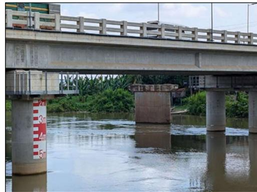
写真 6 橋桁までの高さ標示 (Prek Chhlong 橋)
