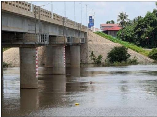
写真 5 橋桁までの高さ標示 (Peam Te 橋)
