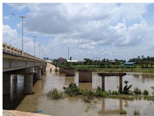
写真 7 仮設橋の橋脚（Peam Te 橋）
