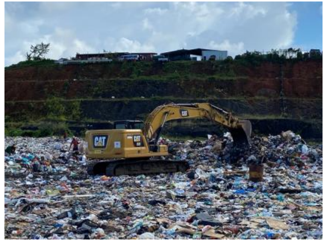
写真 2：廃棄物を埋め立てるエクスカベーター (出典：外部評価者撮影)
