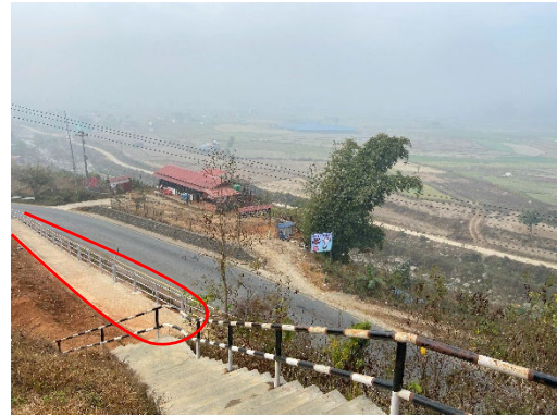
写真⑨ 新設された歩道（赤枠）
