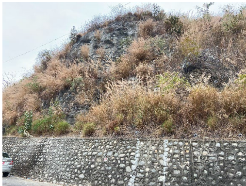
写真⑥Sta.15+520 のアンカー工
