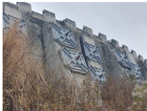
写真③Sta.33+440 のアンカー工
