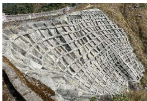
写真①本事業により整備されたアンカー工 1
