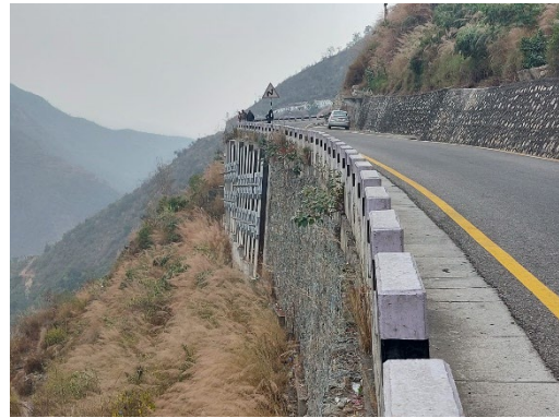
写真⑤Sta.11+620 のアンカー工
