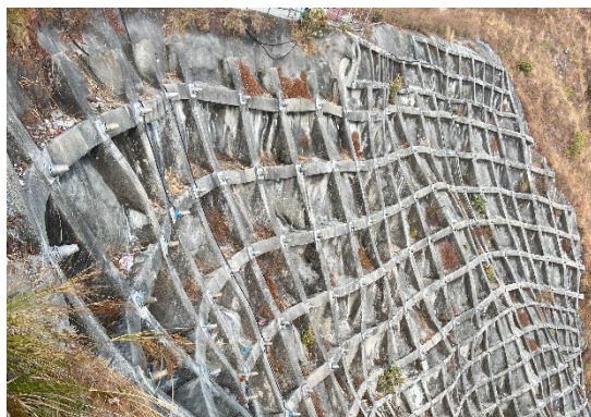
写真②Sta.17+400 のアンカー工
