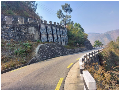
写真④Sta.33+695 のアンカー工
