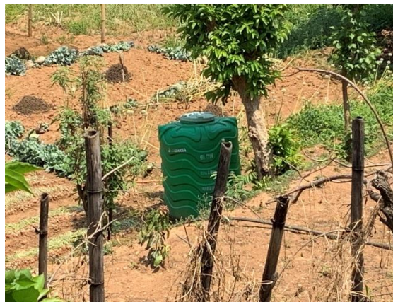
灌漑用貯水槽・パイプ カブレ郡 Roshi Rural Municipality
