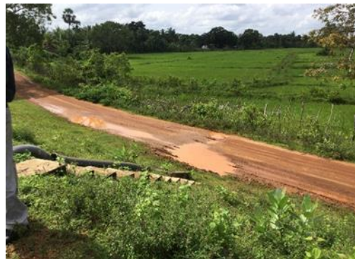
リンク水路によって、雨季の洪水被害が軽減された。
