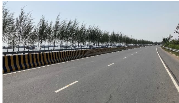
チッタゴン環状道路本線（開始地点約 2km 付近、片側 2 車線及び中央分離帯の様子） （出所：評価者撮影）
