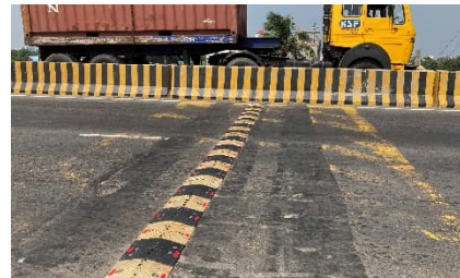
写真 4: 一部が撤去されたスピード ブレーカー (評価者撮影)
