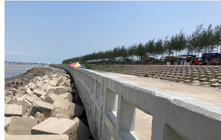
写真 1: 追加された本線海側の堤防歩道と波返し壁の様子（開始地点約 2km 付近）（評価者撮影）
