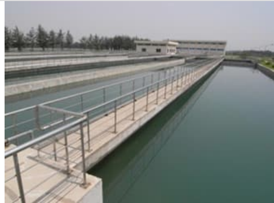
事業にて建設された浄水場（2024年4月、評価者撮影）
