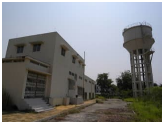
写真 3. 配水池及び高架水槽（2024 年 4 月、評価者撮影）
