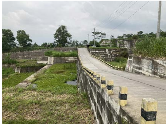
写真3: 通行可能な砂防施設 (天端に道路が敷設されている) (出典：評価者撮影)
