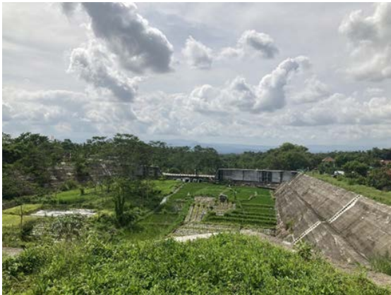
写真 1：遊砂地（ゲンドール川） （出典：評価者撮影）
