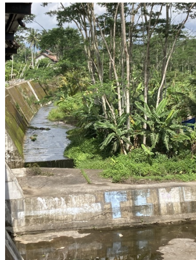
写真4: 放水路 (プティ川) 左側に 灌漑用分水路が設置 (出典：評価者撮影)
