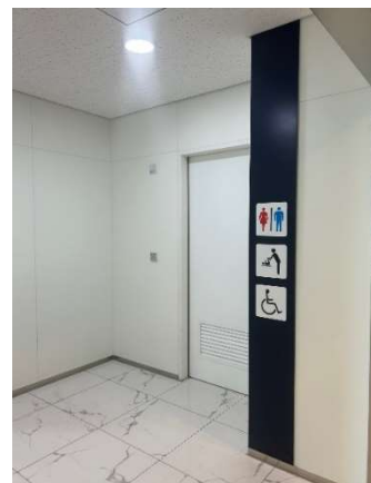
写真 5 設置された多目的トイレ
