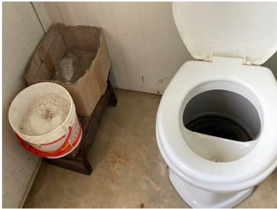
コンポスト式トイレ（小便と大便を分離する） 乾燥材（灰・おが屑）
