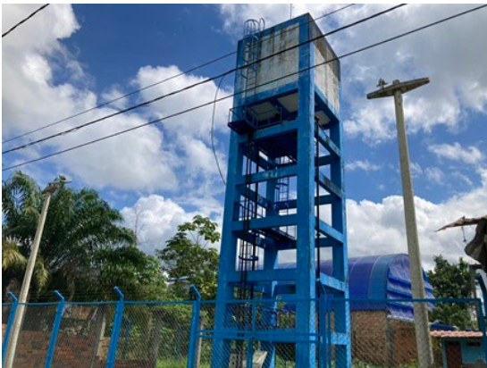
高架式配水池（地下水をポンプで組み上げる給水施設）
