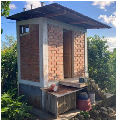
基礎衛生ユニット(レンガ造り)
