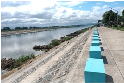
写真1：カガヤン川サブプロジェクトで整備された護岸壁・水制工
