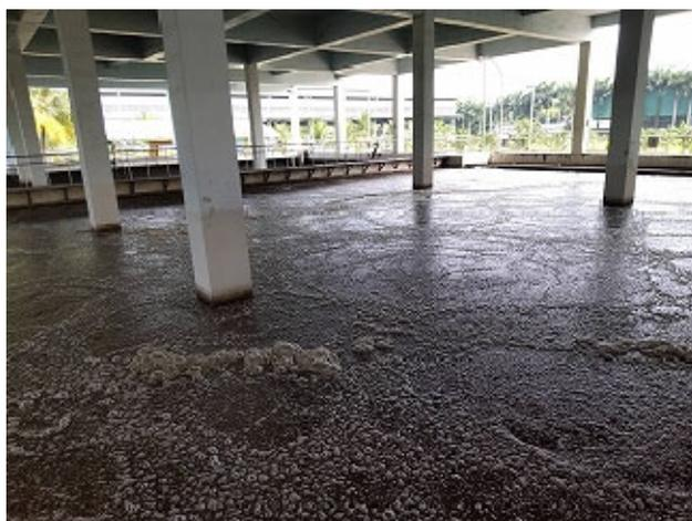
写真 2：ベトナム初の回分式反応槽による処理方法（ASBR）
