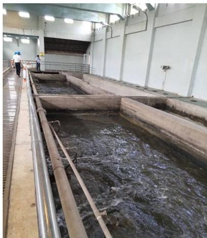
写真 1：沈砂池（大きなゴミを取り除き土砂類を沈殿させる池）
