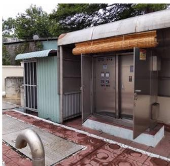
写真7：中継ポンプ内に設置した脱臭装置（左）
