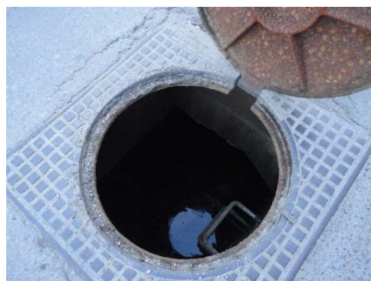
アン・キム・ハイ排水路のマンホール （出典：評価者撮影）
